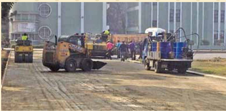
110 年 2 月 1 日合成橡膠跑道施工鋪柏油情形（總幹事 鍾源旺 攝影）
